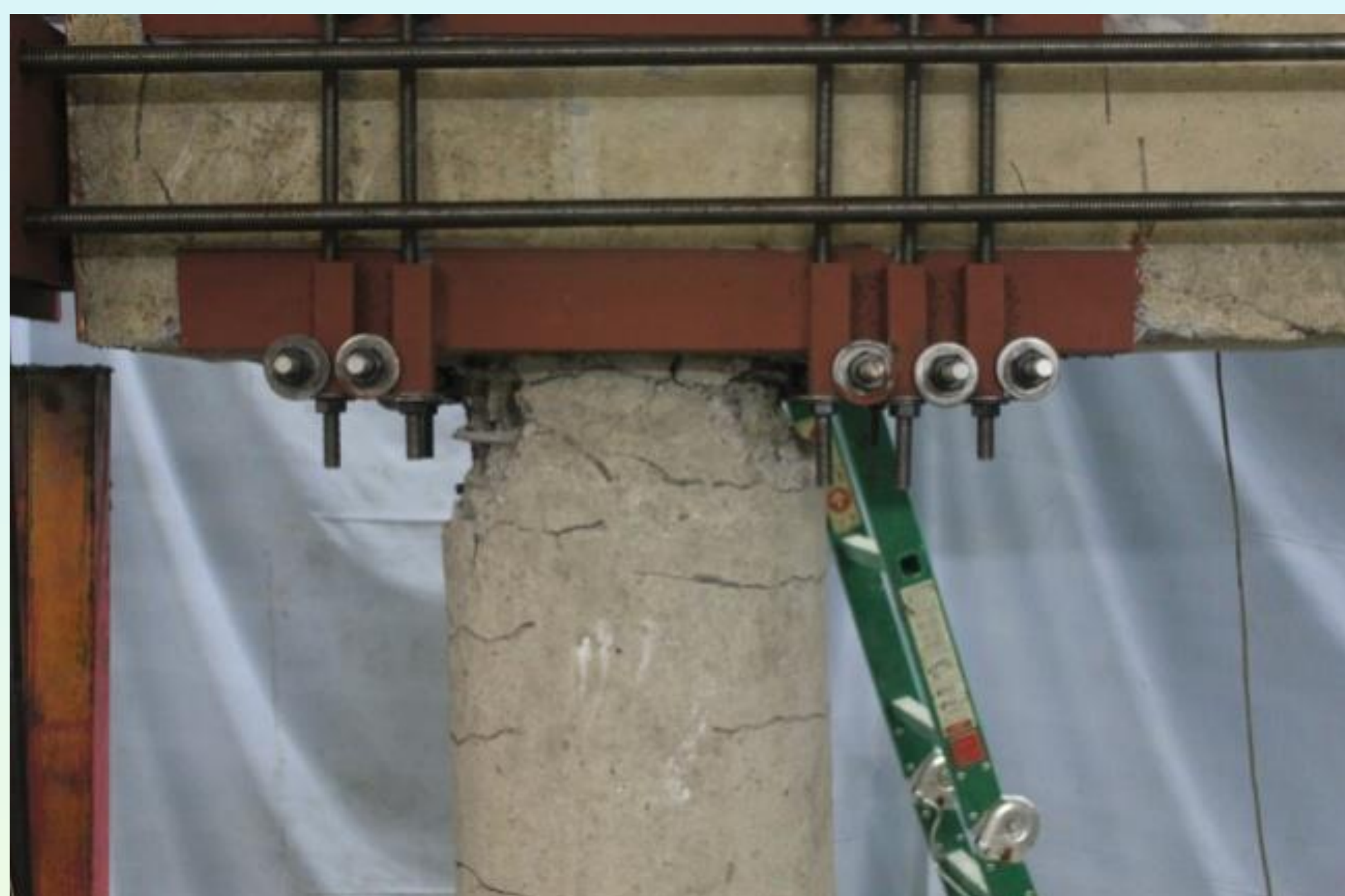
شکل گیری کامل مفصل پلاستیک خمشی در ستون و عدم خسارت در تیر سرستون (نمونه بهسازی شده A.3)
